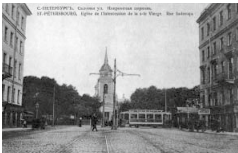
Покровская церковь. Колокольня. Вид с Садовой ул. Начало XX в. Открытка. ГМИ СПб
